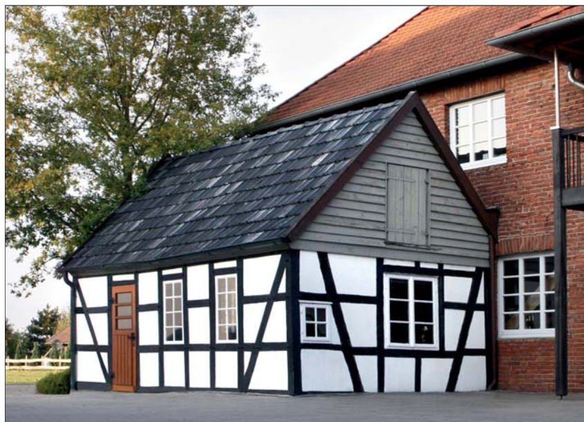
Das schicke Fachwerkgebäude von 1859 ist die Keimzelle von Düvel.
